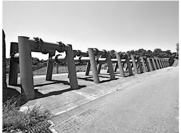
大金沢砂防ダム
